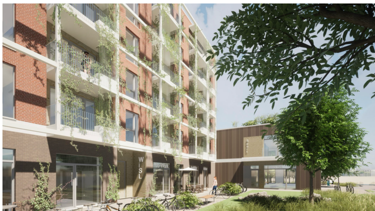
Ansicht von Südwest auf Eingangsbereiche
